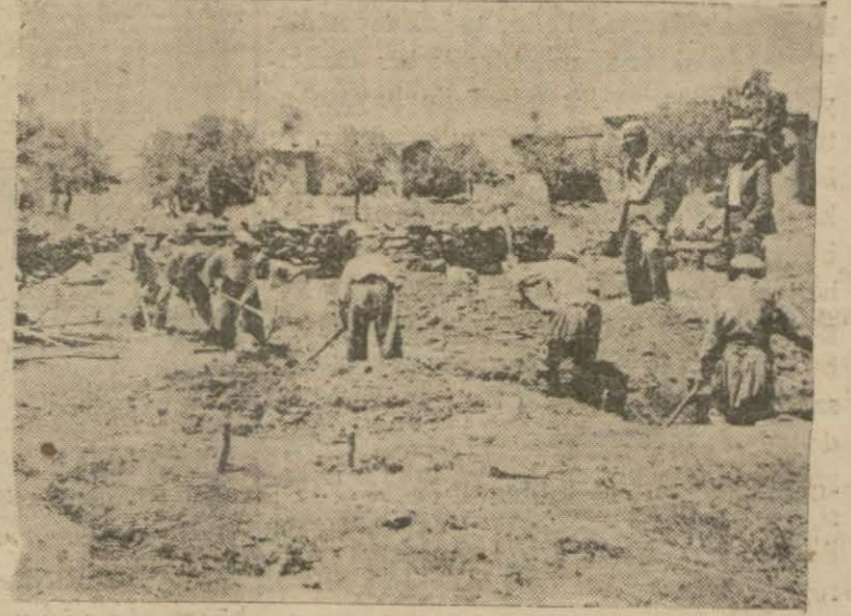
Halkevi inşa edilecek saha temizlenirken
